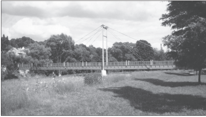
Grazil überspannt die Stegbrücke die Flöha mit einer Länge von 82 Metern, 2,50 Meter Breite bei einem Gewicht von 61 Tonnen. 6 Die hölzerne Konstruktion fügt sich dabei hervorragend in unsere vorerzgebirgische Landschaft ein. Archiv Lothar Schreiter
