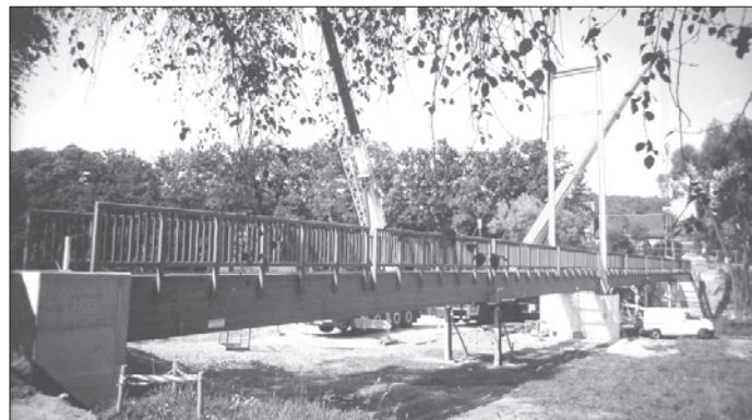
Die dritte, diesmal hölzerne Stegbrücke während ihrer Montage Archiv Lothar Schreiter
